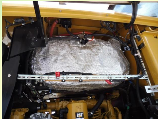
エンジンルーム内
